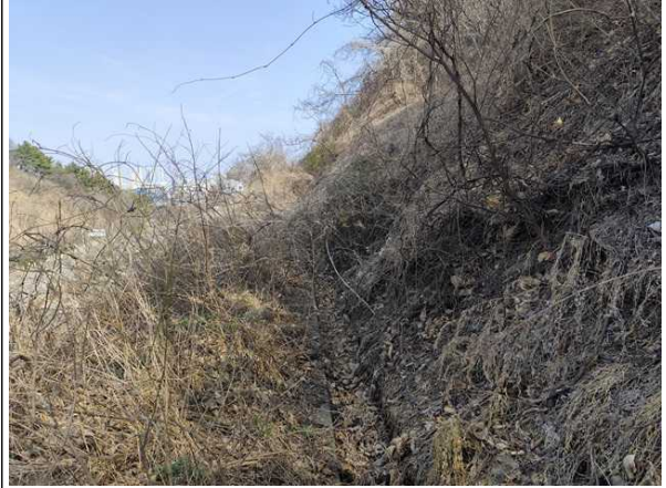
2소단 배수로 전경
