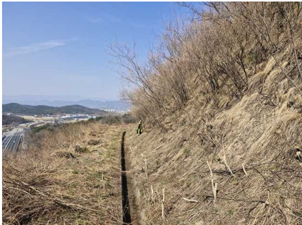
3소단 배수로 전경
