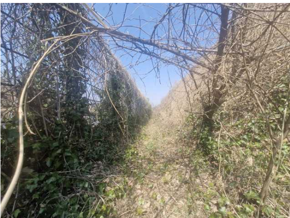
낙석방지울타리 및 하부 전경
