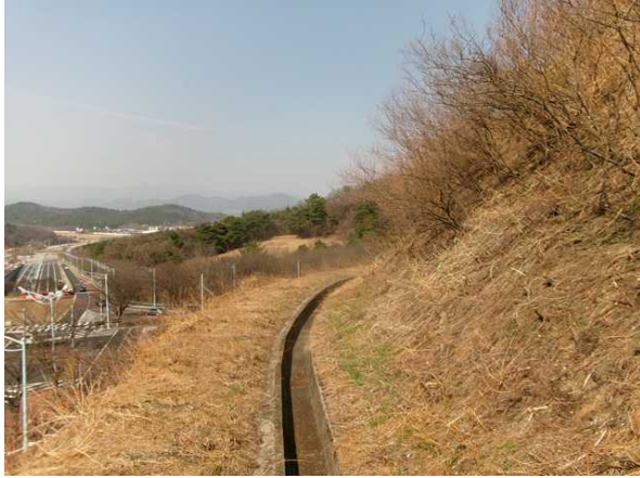
1소단 배수로 전경
